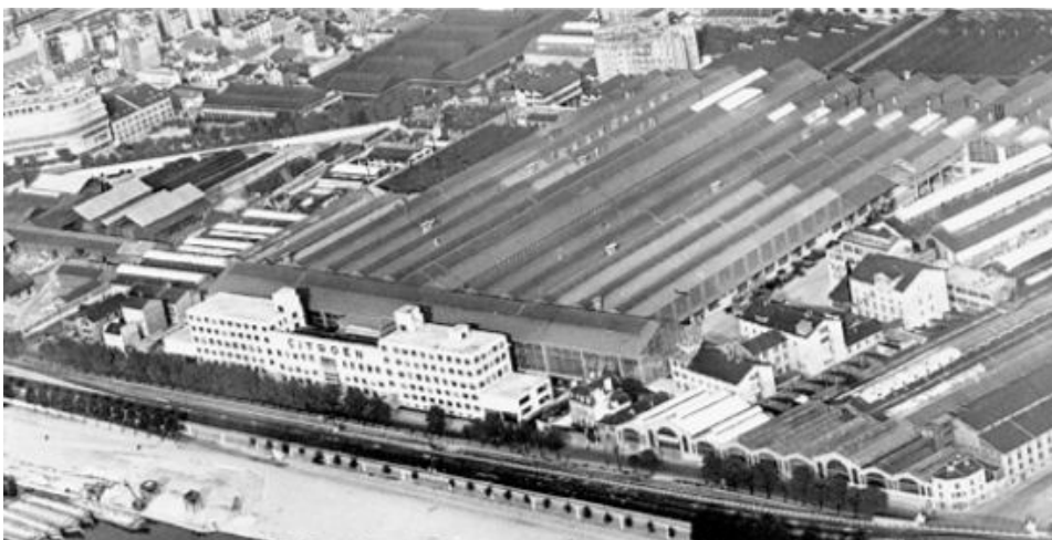
■ La grande usine du Quai de Javel.
